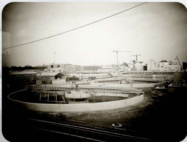
Foto: Oczyszczalnia ścieków Czajka w Warszawie
