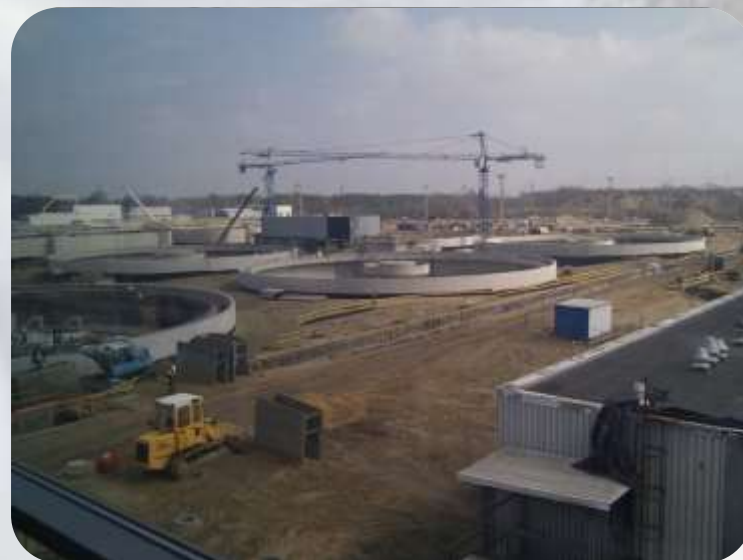
Foto: Budowa oczyszczalni ścieków Czajka w Warszawie
